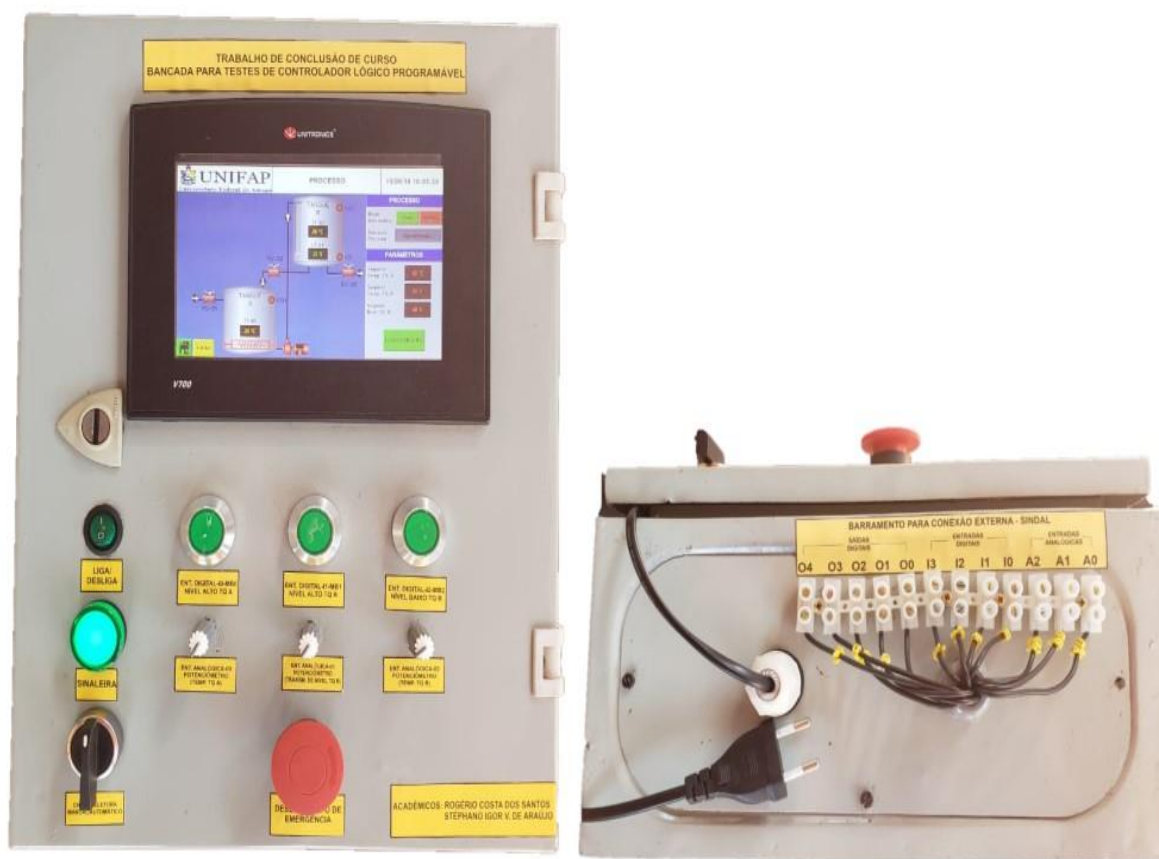
Figura 24 – Caixa de comando finalizada
