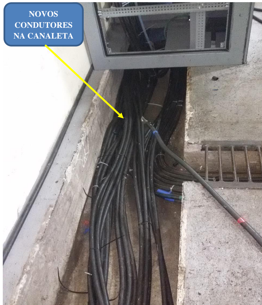
Figura 37 – Canaleta já com alguns novos condutores
