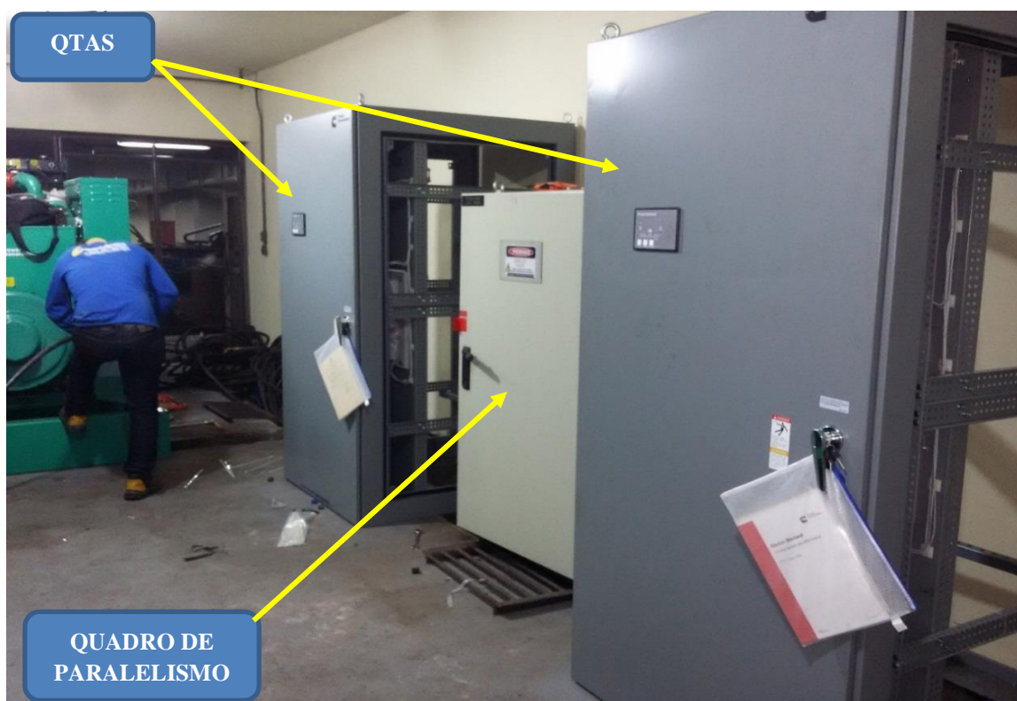
Figura 29 – Acomodação final dos Quadros de Paralelismo e Transferência
