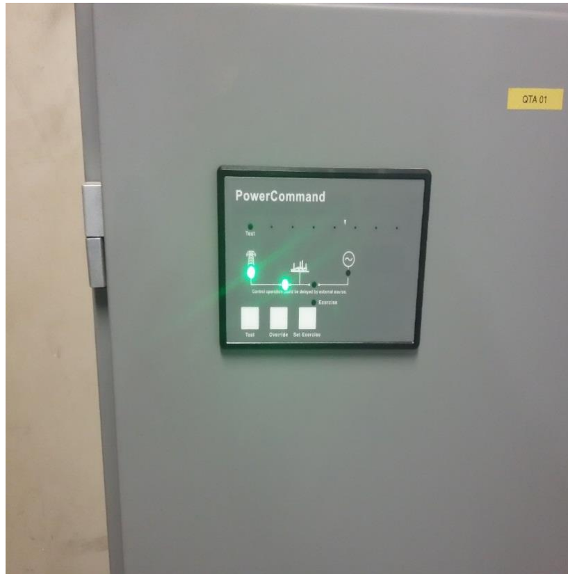
Figura 39 – Um dos QTAs com os leds CEA-carga normais
