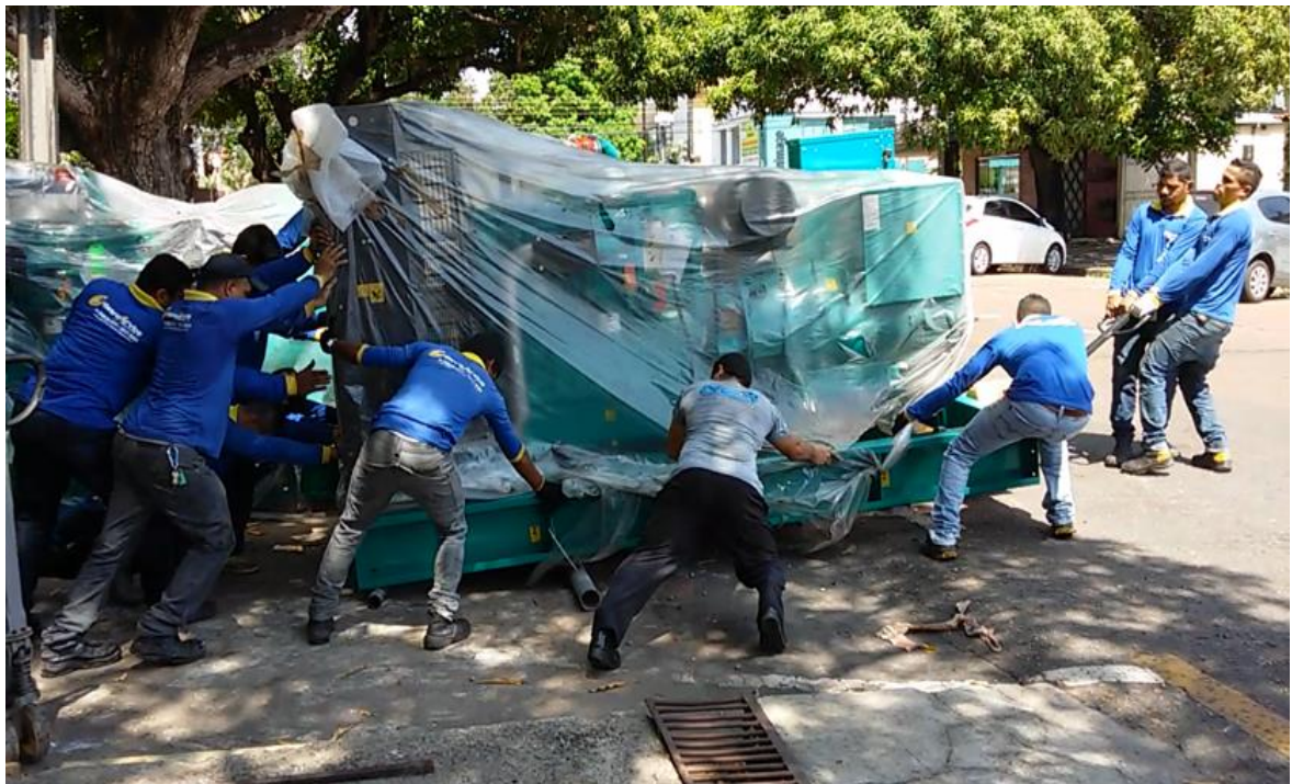
Figura 26 – Transporte dos GMGs para a subestação
