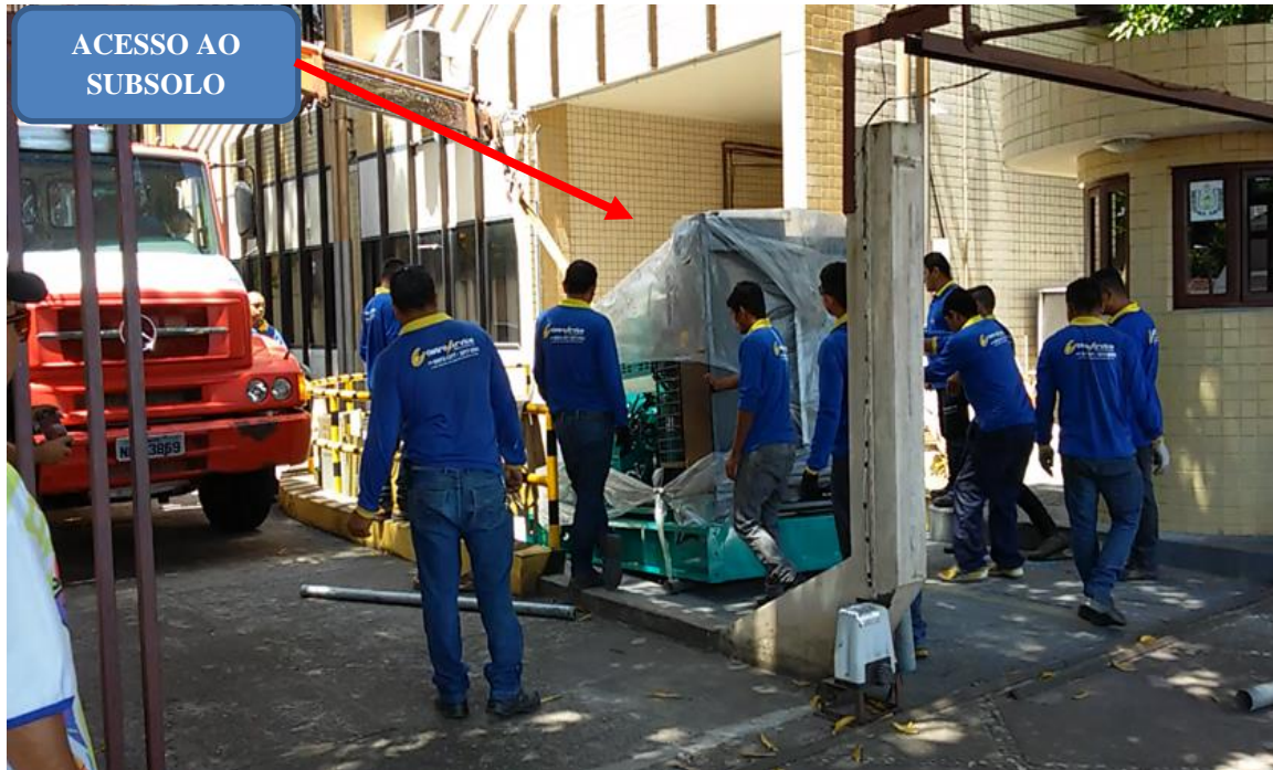
Figura 27 – Transporte dos GMGs na entrada do subsolo do TJAP
