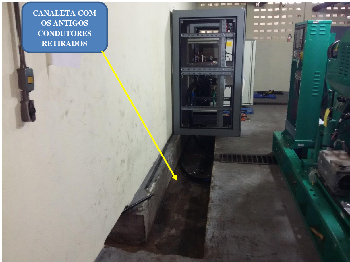
Figura 35 – Canaletas limpas prontas para receber os novos condutores
