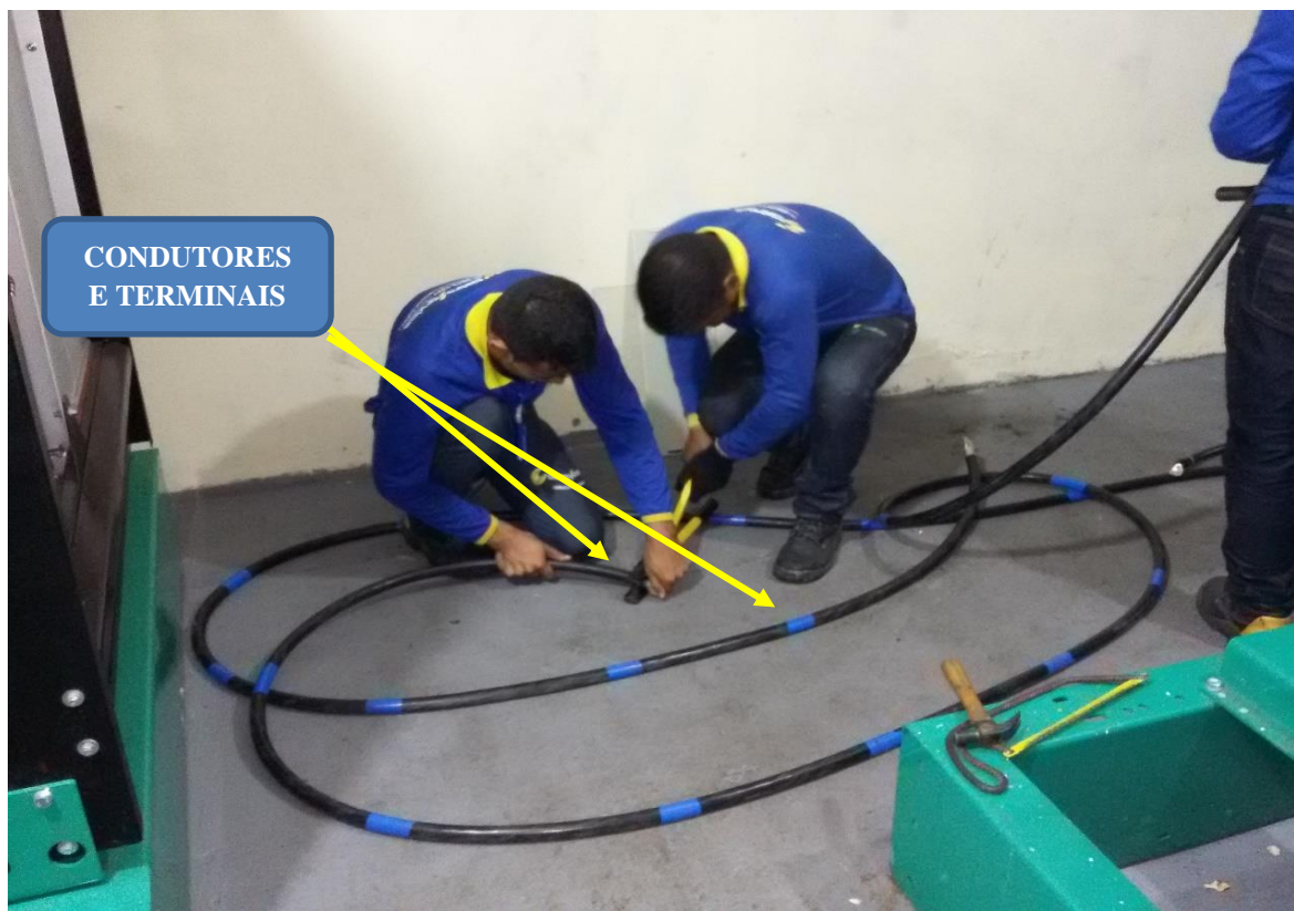
Figura 30 – Comprimento dos condutores e colocação dos terminais
