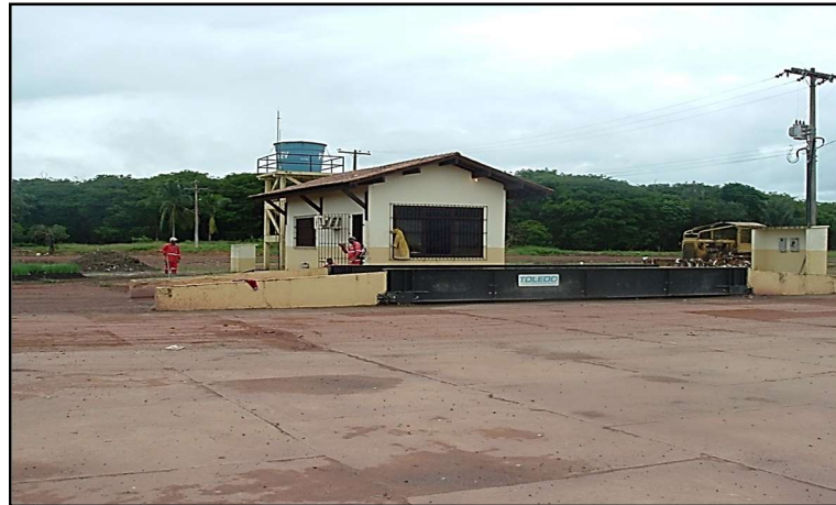
Figura 17 - Balança de pesagem dos caminhões no CTR de Macapá.
