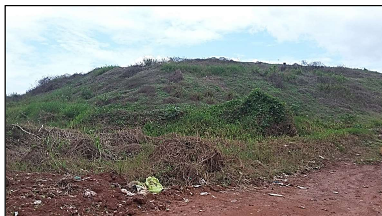
Figura 18 - Aterro controlado de Macapá.
