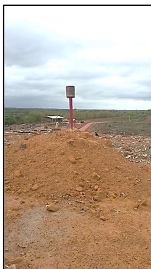
Figura 22 - Queimador de gás do aterro sanitário de Macapá.
