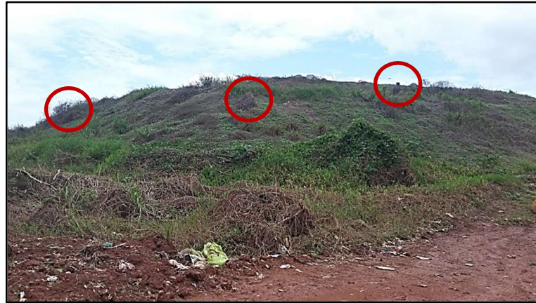
Figura 19 - Drenos do aterro controlado de Macapá.
