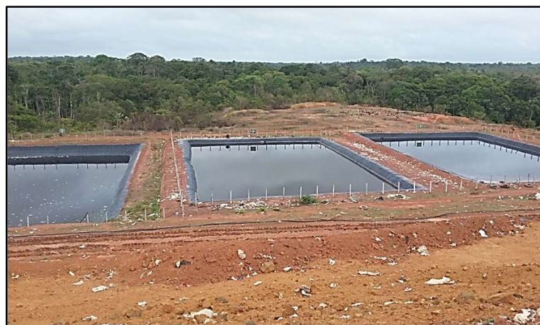
Figura 15 - Lagoas de chorume do aterro sanitário de Macapá.
