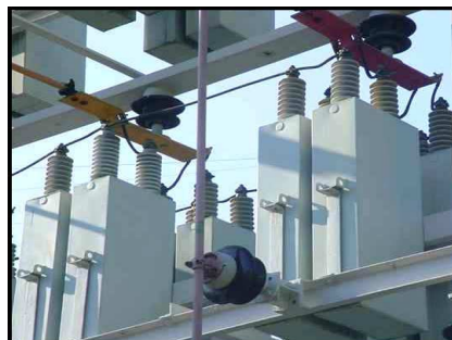
Figura 1.4: Ligação de capacitores em paralelo
