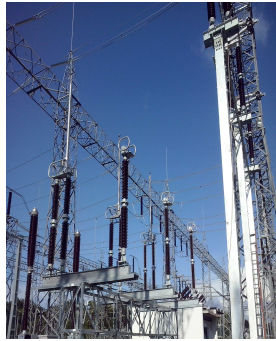
Figura 1.5: Ligação de capacitores em série Fonte: http://lcdassistec.com.br .
