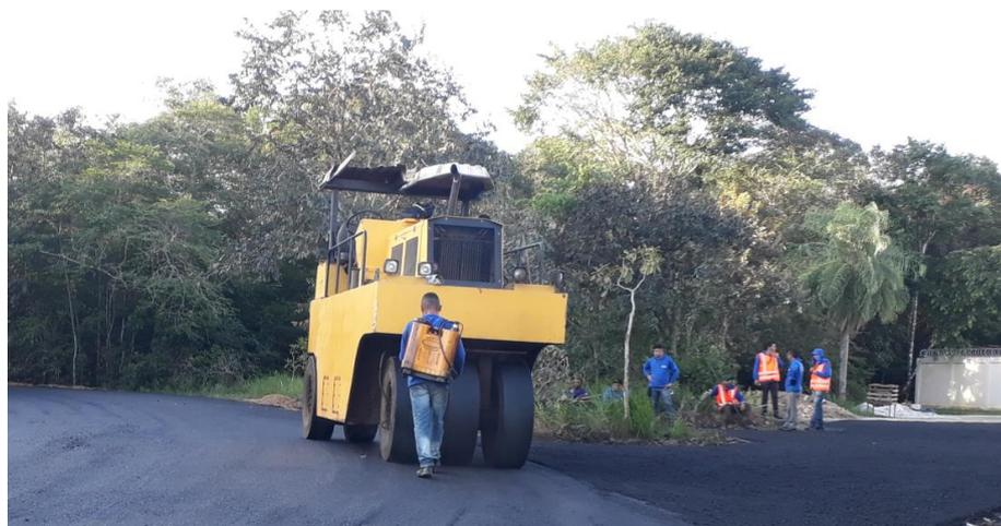
**Figura 23 - Rolo compactador de pneus**
