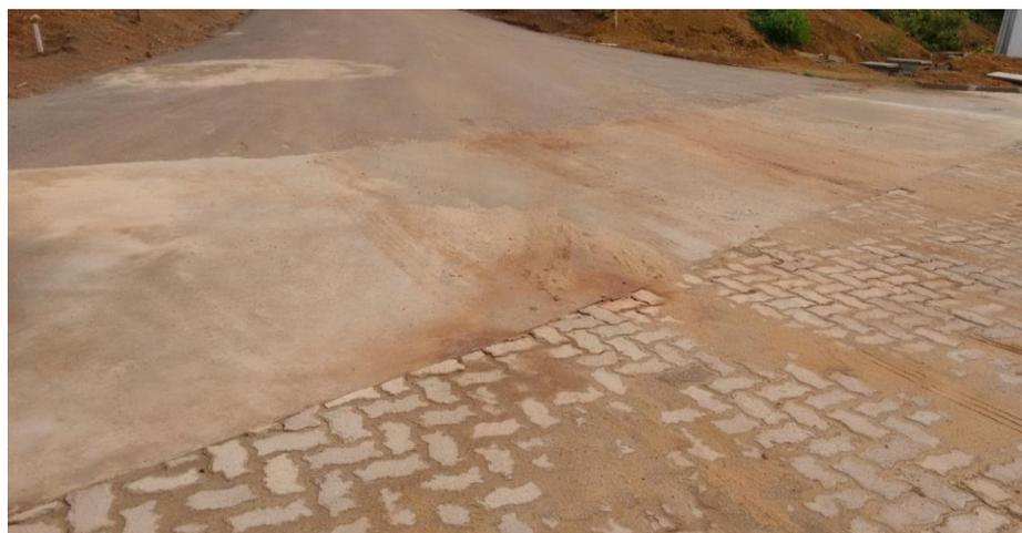
**Figura 43** - Sarjetão em concreto armado entre a Via 01 e o Ram Toca da Onça
