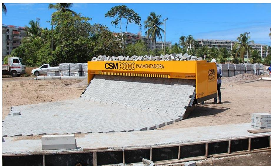
**Figura 34** - Pavimentadora de paver
