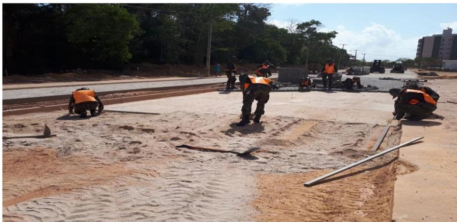
**Figura 42** - Serviço de pavimentação de blocos Intertravados da Via 01
