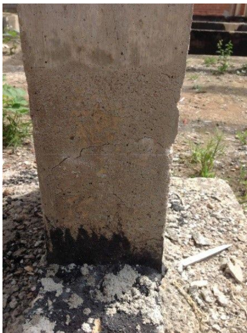
Figura 14 - Fissura - Pilar 14
