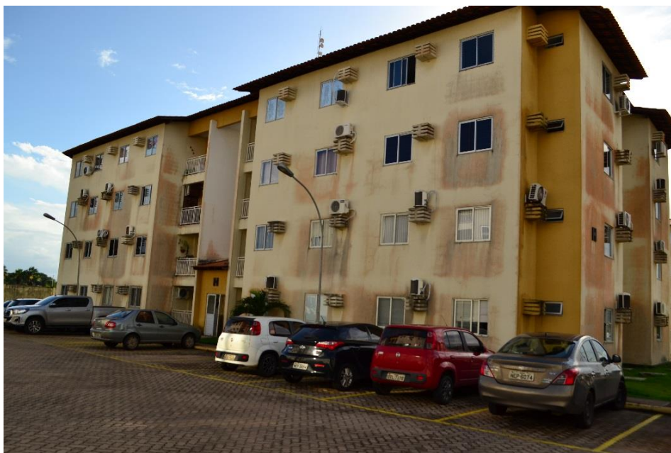
Figura 35 - Fachada principal do edifício F
