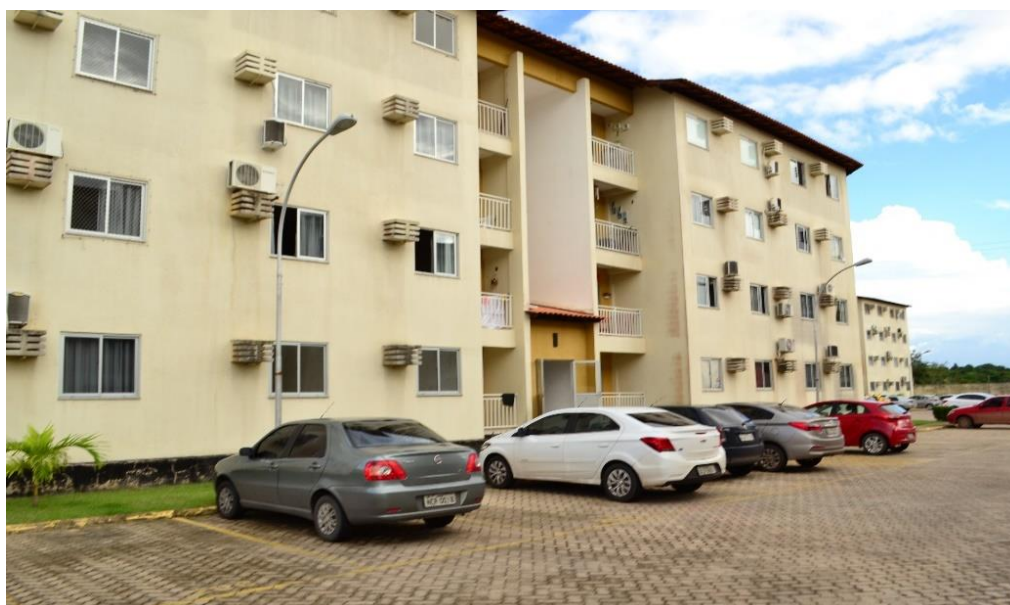
Figura 38 - Fachada principal de entrada do Edifício I
