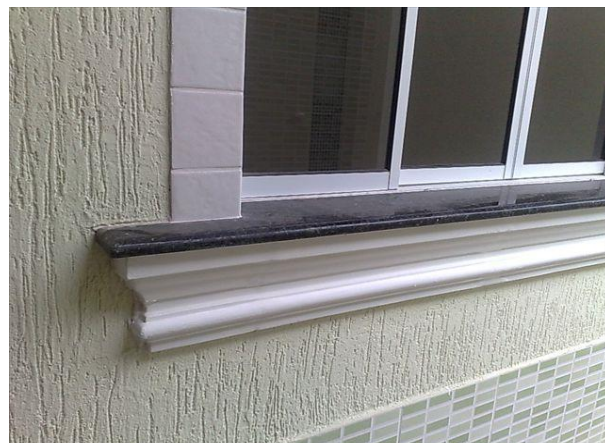
Figura 15 - Pingadeira fazendo proteção de peitoril de janela
