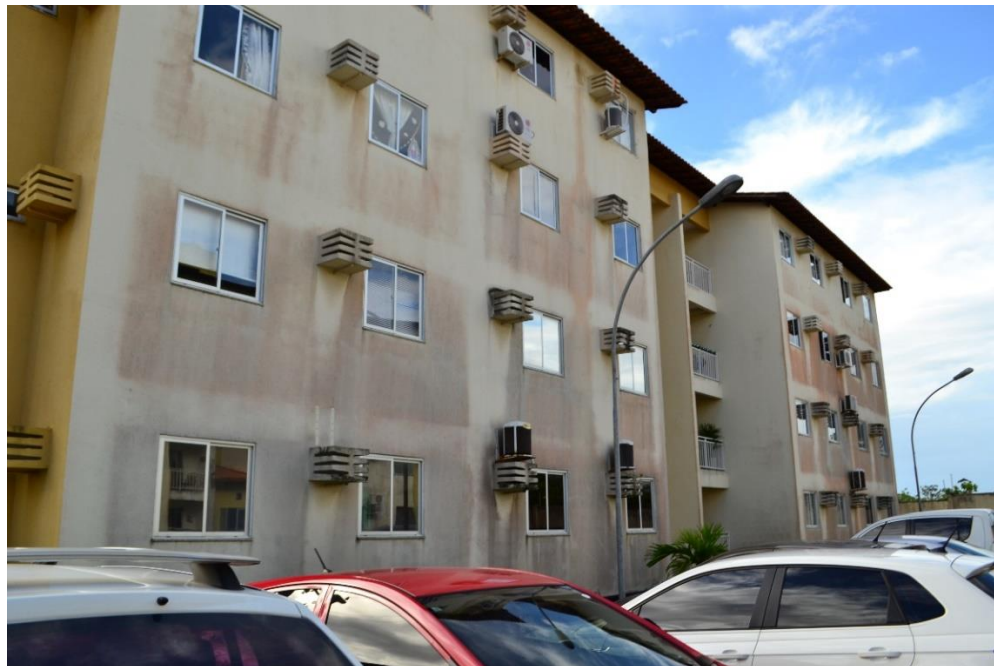
Figura 37 - Fachada posterior do Edifício M
