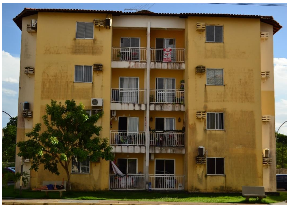
Figura 36 - Fachada lateral (B) do Edifício D
