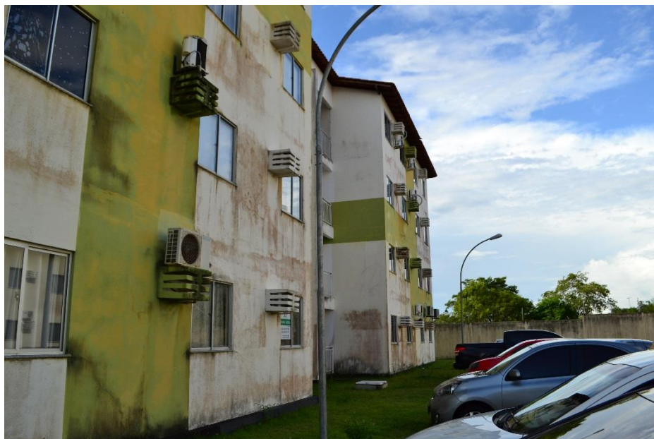
Figura 39 - Fachada posterior do Edifício E
