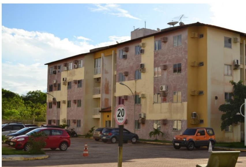
Figura 33 - Edifício D do condomínio
