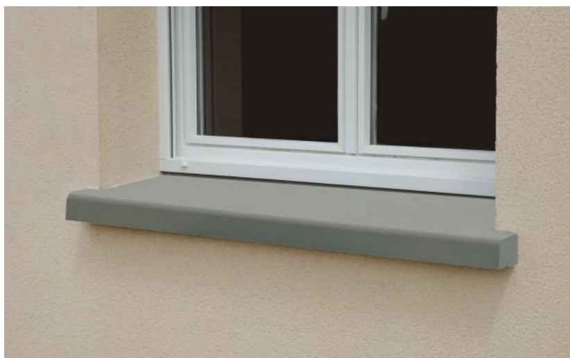
Figura 13 - Detalhe do peitoril
