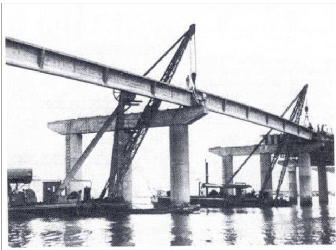
Figura 1.1 - Primeira Ponte do Galeão-Rio de Janeiro 1948 (MONDORF, 2006 apud PINHO; REGIS; ARAÚJO, 2011).
