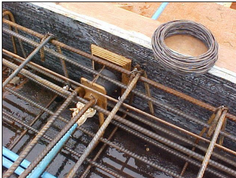
Figura 2.18 – Ancoragem ativa de cordoalha engraxada (BASTOS, 2018).
