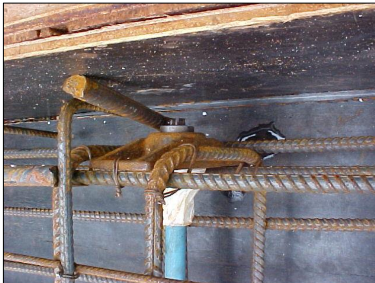
Figura 2.19 - Ancoragem passiva de cordoalha engraxada (BASTOS, 2018).
