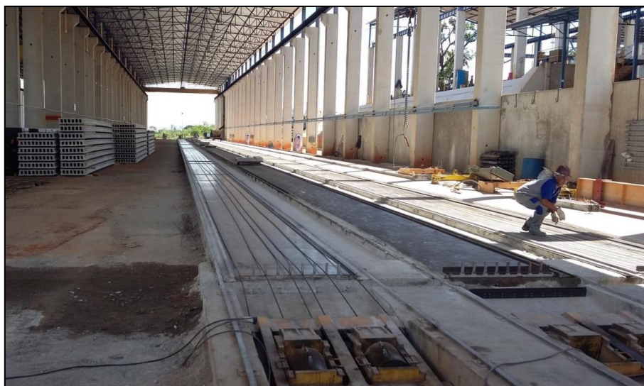
Figura 2.14 - Pista de protensão para fabricação de laje alveolar (BASTOS, 2018).
