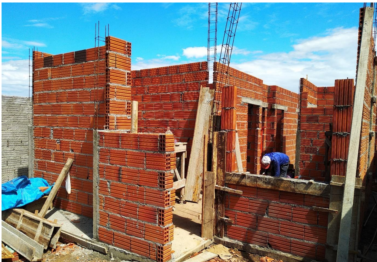
Figura 6 - Casa com paredes de 3,0 m de altura
