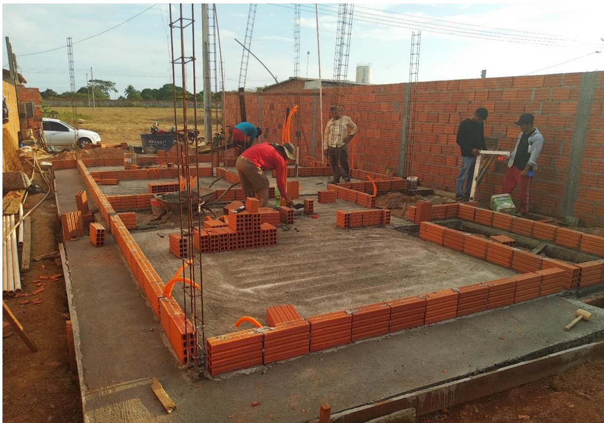
Figura 4 - Início da alvenaria, primeira fiada
