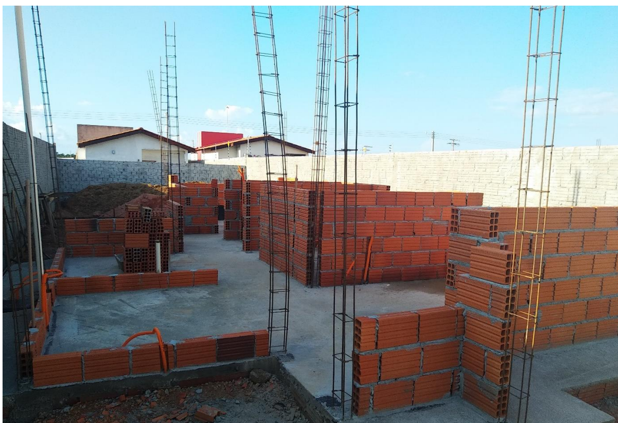
Figura 5 - Casa com paredes de 1,5m de altura
