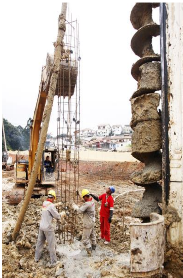
Figura 6 Posicionamento da armadura de uma fundação por estaca hélice contínua
