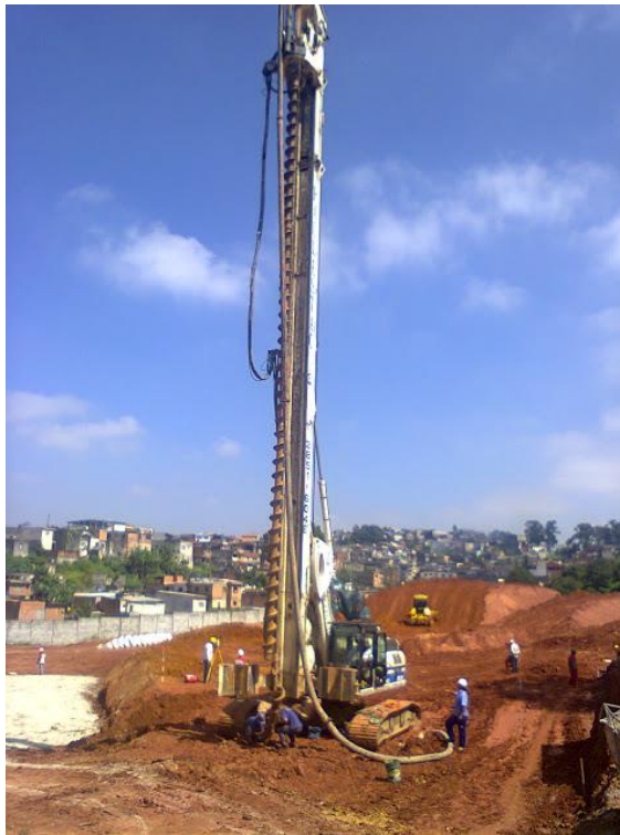
Figura 2 Maquinário para execução de estacas hélice contínua
