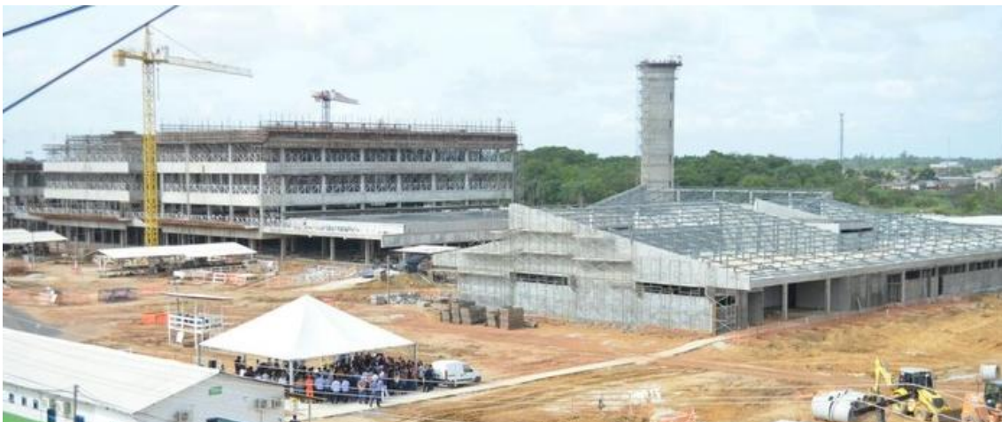
Figura 12 Hospital Universitário da UNIFAP em fase de construção
