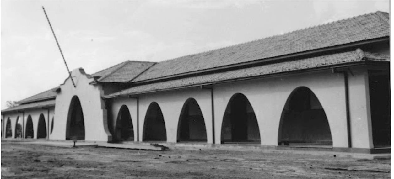
Imagem 2 – Registro Fotográfico da Fachada da antiga Escola Industrial de Macapá (ano desconhecido)
