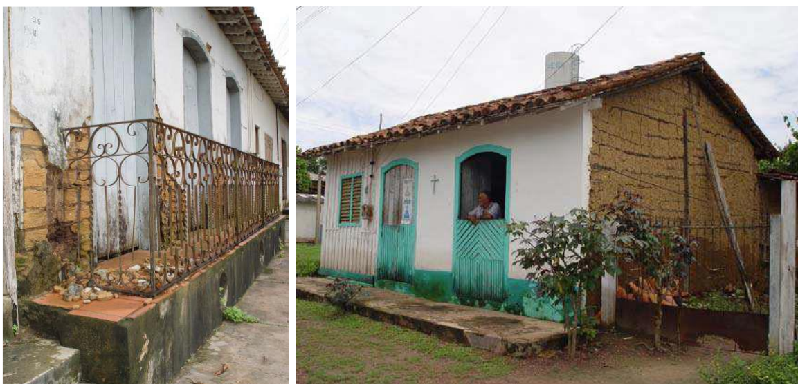
Figura 3: Do lado esquerdo a casa de taipa, com o gradil do século XX; lado direito casa de taipa destruída em 2002.
