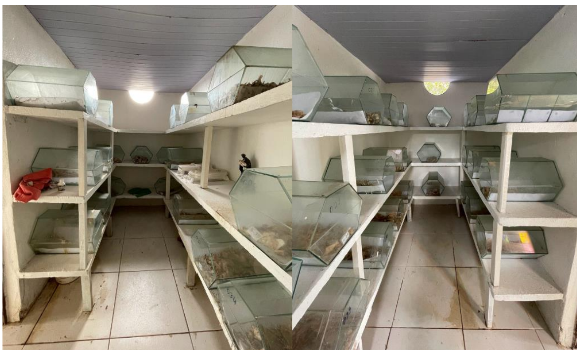
Figura 15: Vista da parte interna do mausoléu, onde ficam acondicionados os remanescentes humanos, acima temos a visualização do forro e abaixo das manchas devido ao acúmulo de água no chão, 2024.
