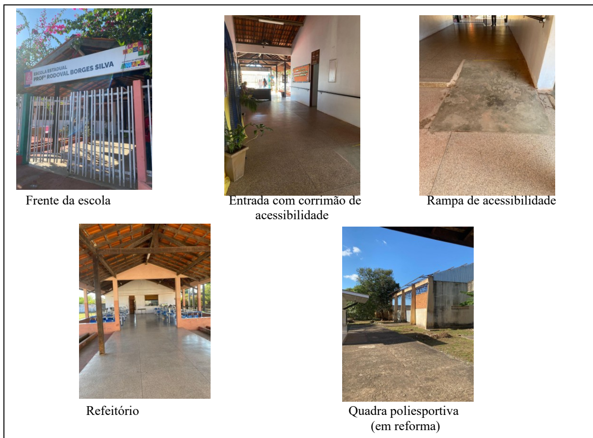
Figura 2: Estrutura da Escola Rodoval Borges
