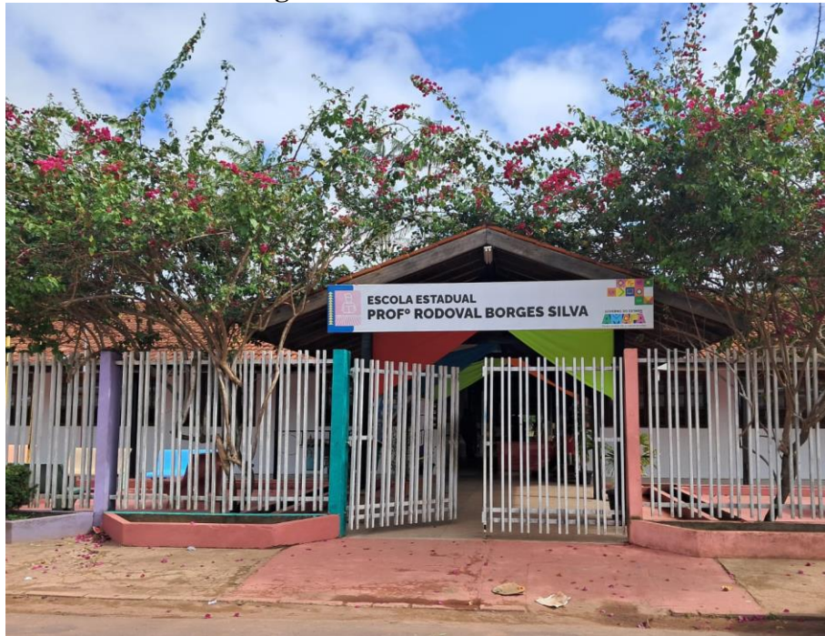
Imagem 1 - Fachada da Escola.
