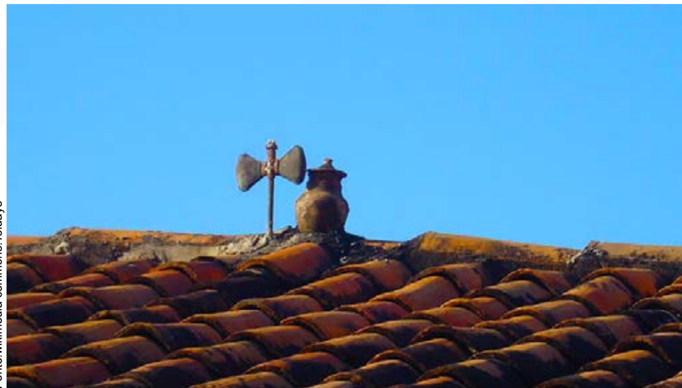
Telhado do Terreiro da Casa Branca
