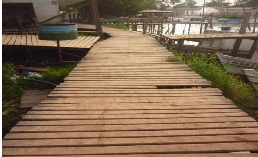
Figura 16 – Trecho da Ponte Beira-rio, em madeira, com Risco de desabamento
