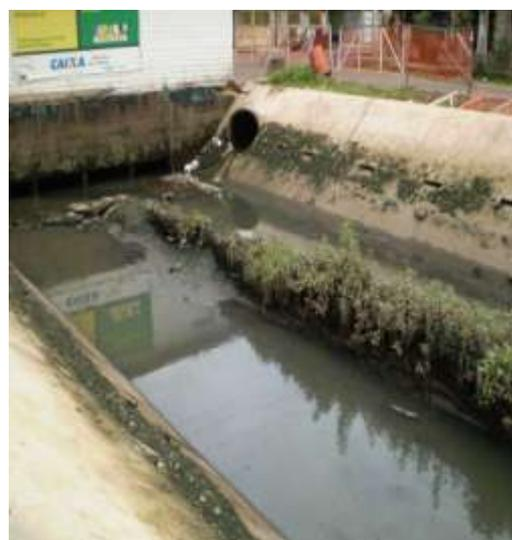
Foto 07: Lançamento de água servida no final do canal (PRODEMAC).
