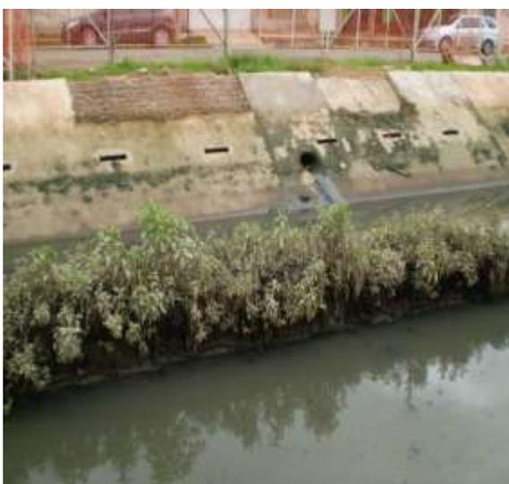
Foto 06: Lançamento de água servida diretamente no canal (PRODEMAC).
