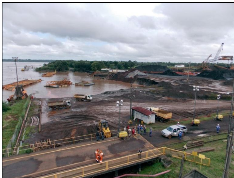
Figura 15 – Queda do porto de Santana, em 28 de março de 2013.
