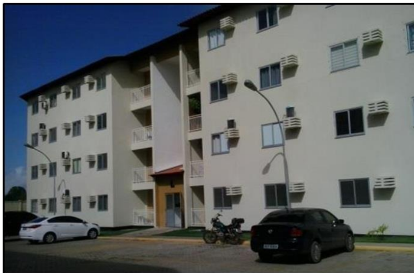
Foto 16: Bloco residencial do Parque Felicitá. Fonte: Trabalho de Campo, 2015.
