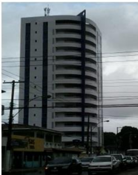
Foto 07: Royal Residence. Fonte: Trabalho de Campo, 2015.
