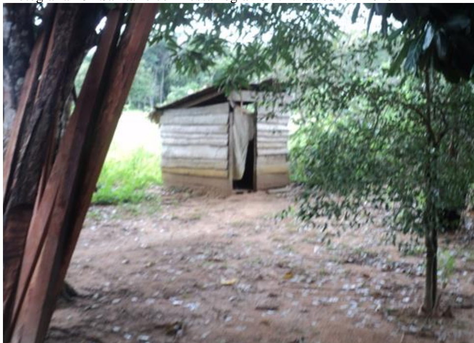
Fotografia 16 - Sanitário com fossa negra no P.A. Itaubal em 2018.
