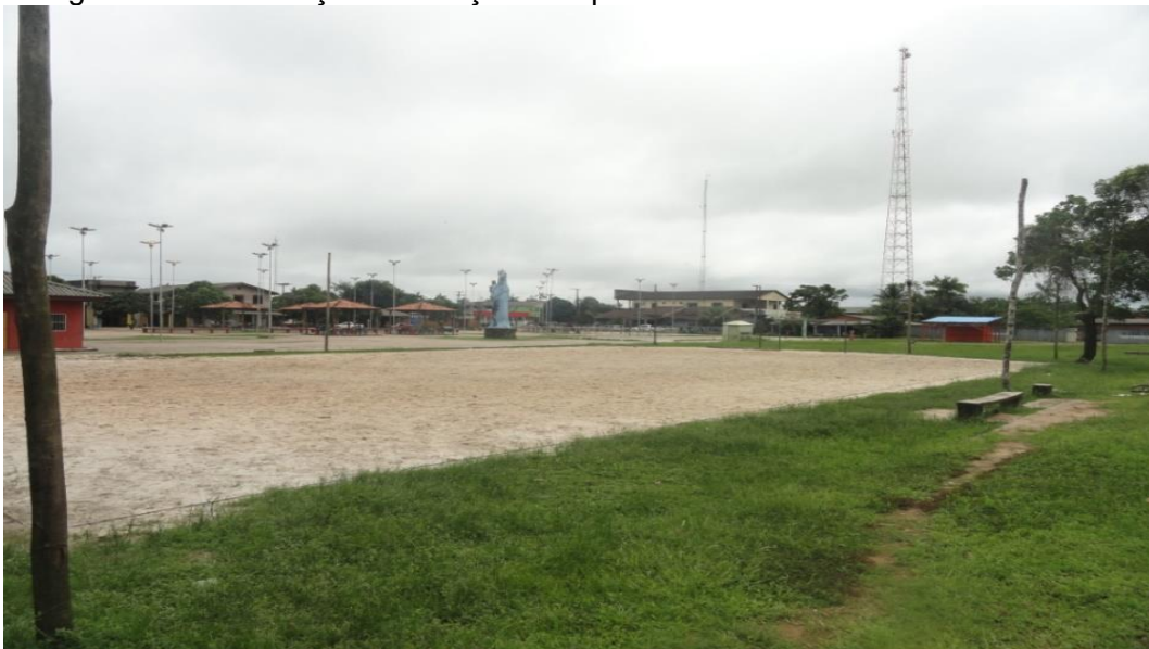
Fotografia 2 - Construção de Praça de Esporte
