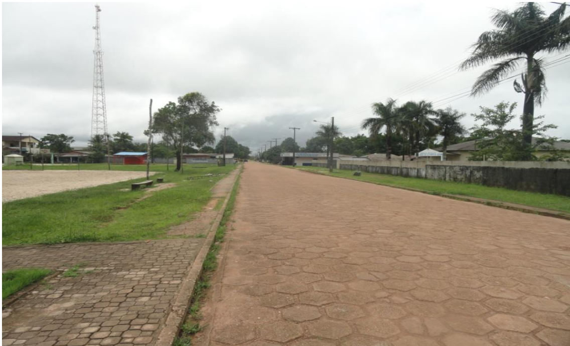
Fotografia 1 - Terraplenagem/pavimentação com blocos articulados, calçada e meio fio na rua mãe verônica
