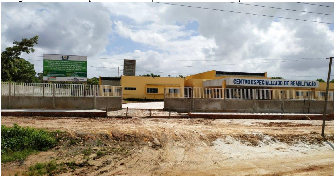
Fotografia 11 - Construção do Centro especializado de reabilitação
