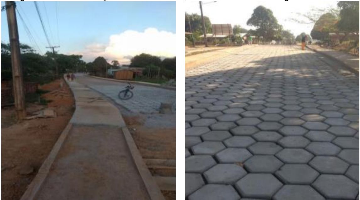
Fotografia 8 - Pavimentação da Av. São Luis, Bairro Central - Tartarugalzinho
