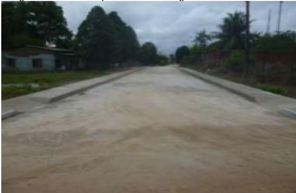
Fotografia 7 - Pavimentação da Rua 25 de agosto no bairro central
