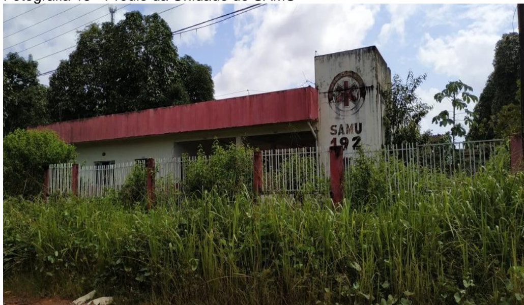
Fotografia 15 - Prédio da Unidade do SAMU
