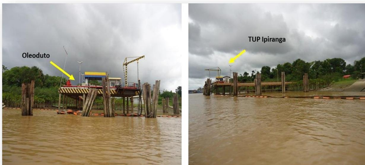
Figura 29: Terminal de Uso Privativo Ipiranga (0° 3' 24.65" S; 51° 11' 5.01" O). Destaque para o oleoduto utilizado para transferência de óleo diesel ao parque de tancagem.
