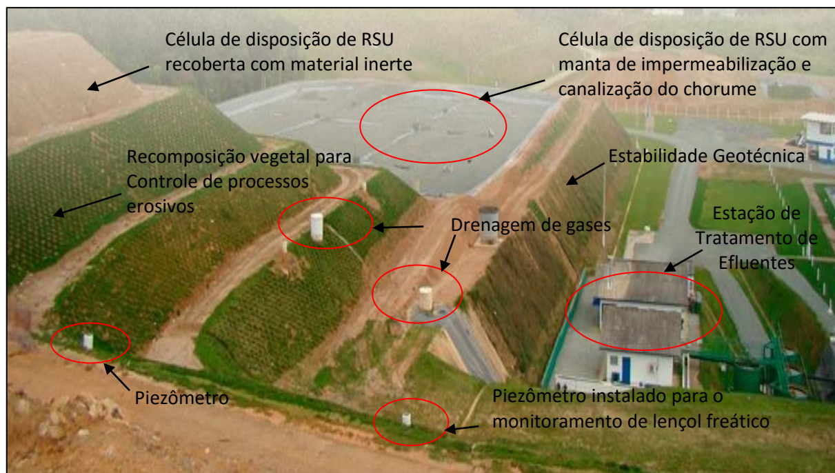
Figura 9 - Modelo de aterro sanitário construído no município de Itajaí-SC, em conformidade com as normas técnicas vigentes. Destaque para as estruturas existentes que orientam a sua construção e operação adequada.
