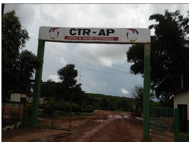
Figura 20 – Acesso principal ao aterro semi-controlado de Macapá.
