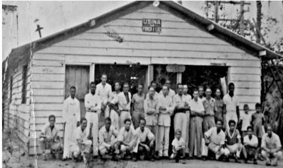
Fotografia 1 - Primeira Usina de Força e Luz de Macapá
