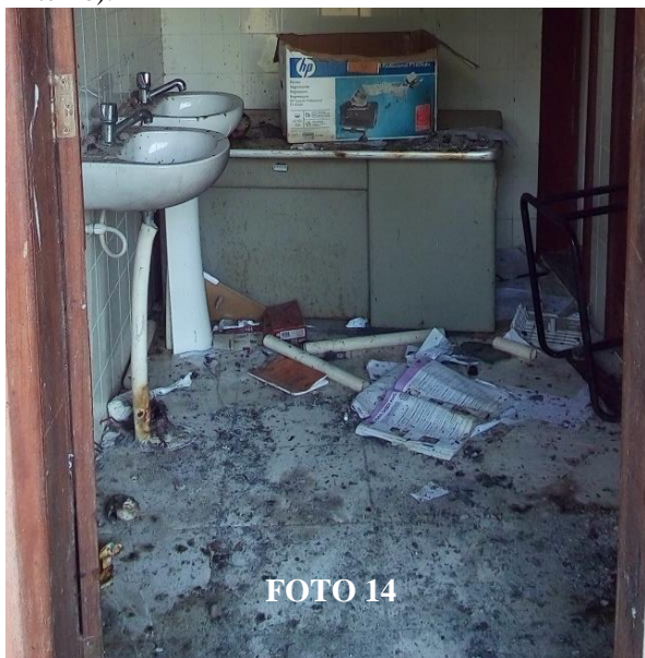
Foto 14 – Escola Família do Maracá (banheiro Externo).
