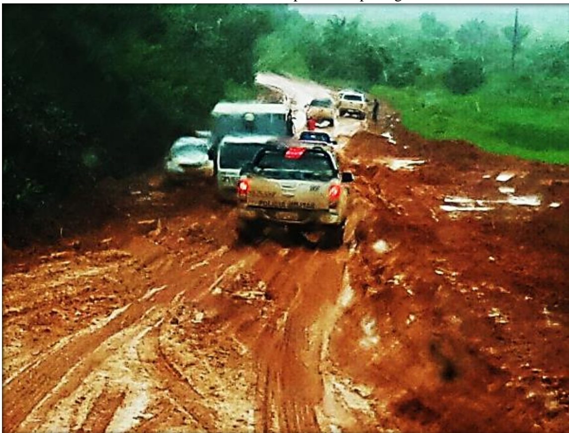
Foto 03: Caminhão atolado na BR-156 impedindo a passagem dos demais veículos.
