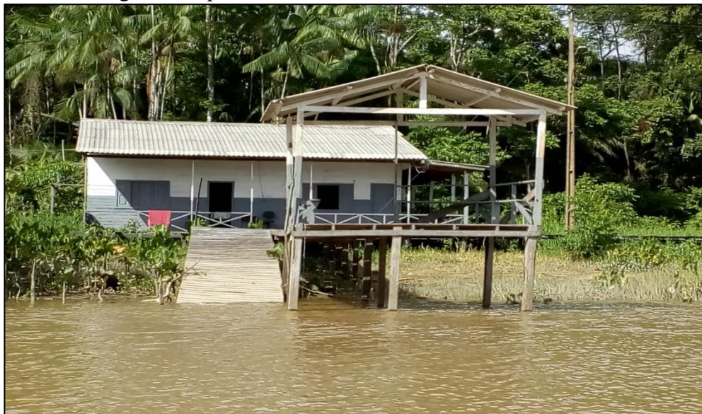
Fotografia 3 - Imagem da base de destacamento da Polícia Militar localizada na Foz do Rio Mazagão, Amapá.
