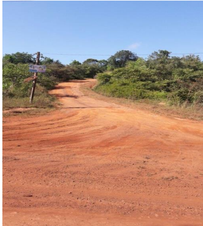
Fotografia 1- Estrada de acesso a Nova Colina, Porto Grande, Amapá.
