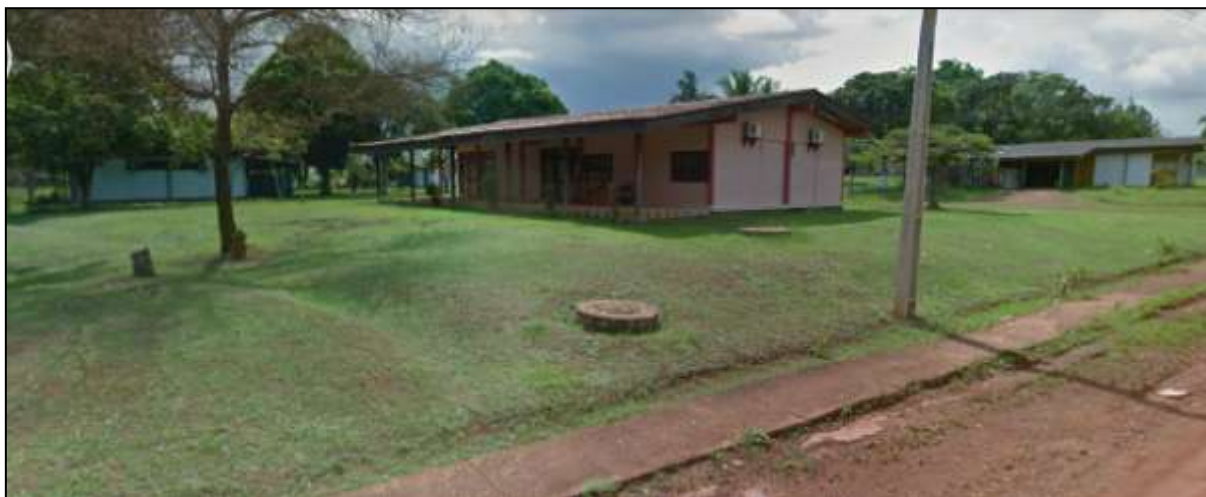
Imagem 2: Foto de Construção em Serra do Navio
