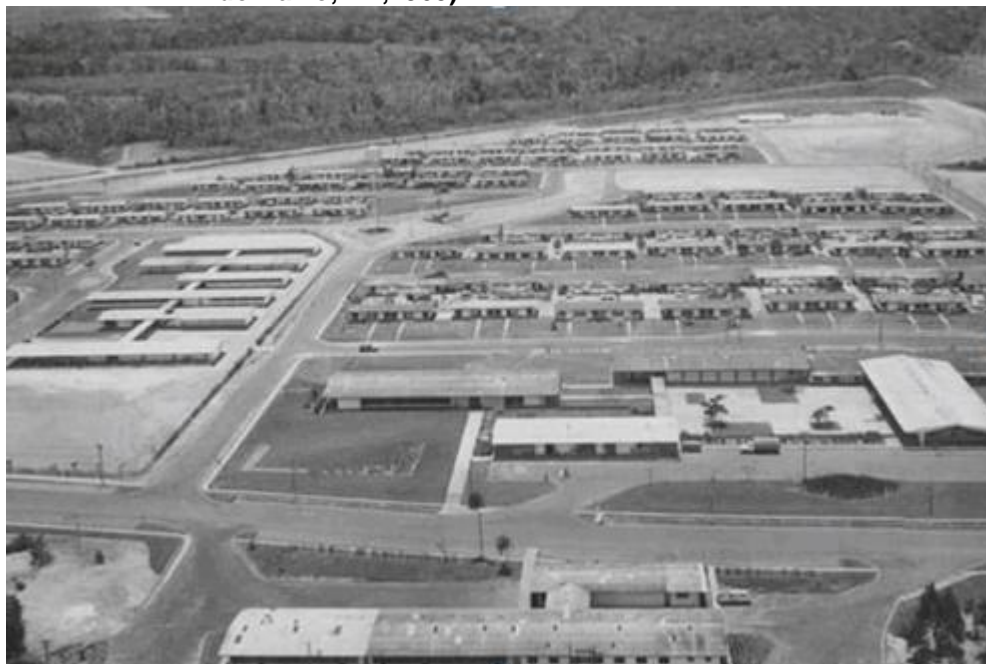
Fotografia 19 - Primário e intermediário (área destinada aos operários) (Serra do Navio, AP,1965).
