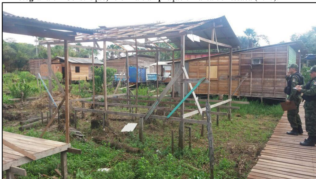
Fotografia 6 – Construção, reforma e ampliação em área de ressaca (2015).
