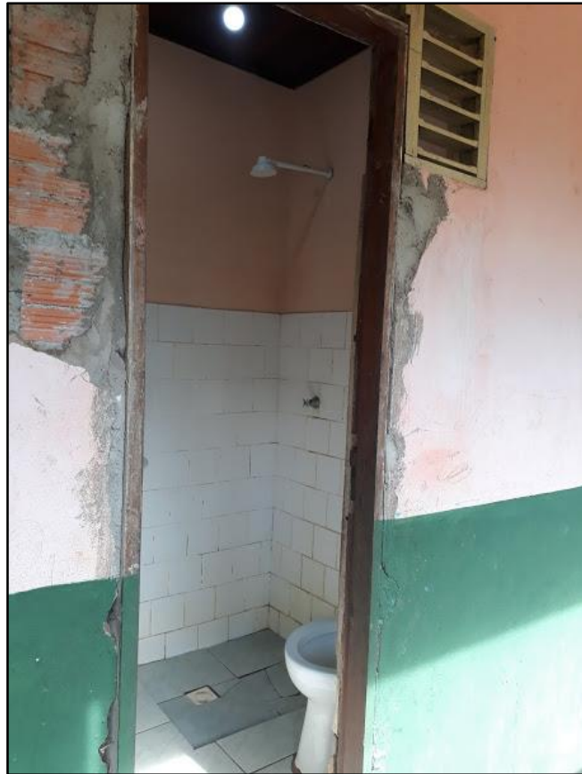
Fotografia 6 ó Instalações do banheiro feminino
