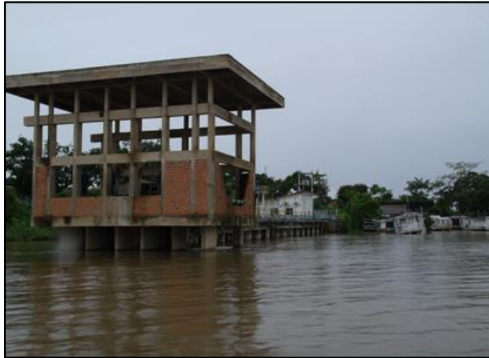
Foto 11 – Sub-estação da CAESA
