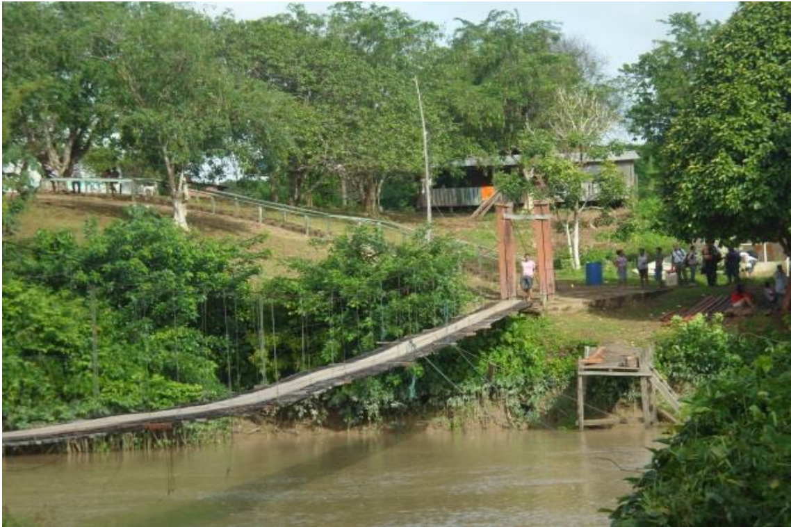
Foto 4: Ponte de acesso à comunidade de Cunani.
