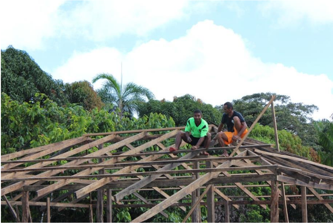
Foto 16: Construção de nova residência na vila.
