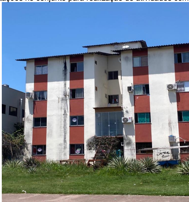
Figura 4 - Adaptações no conjunto para realização de atividades comerciais
