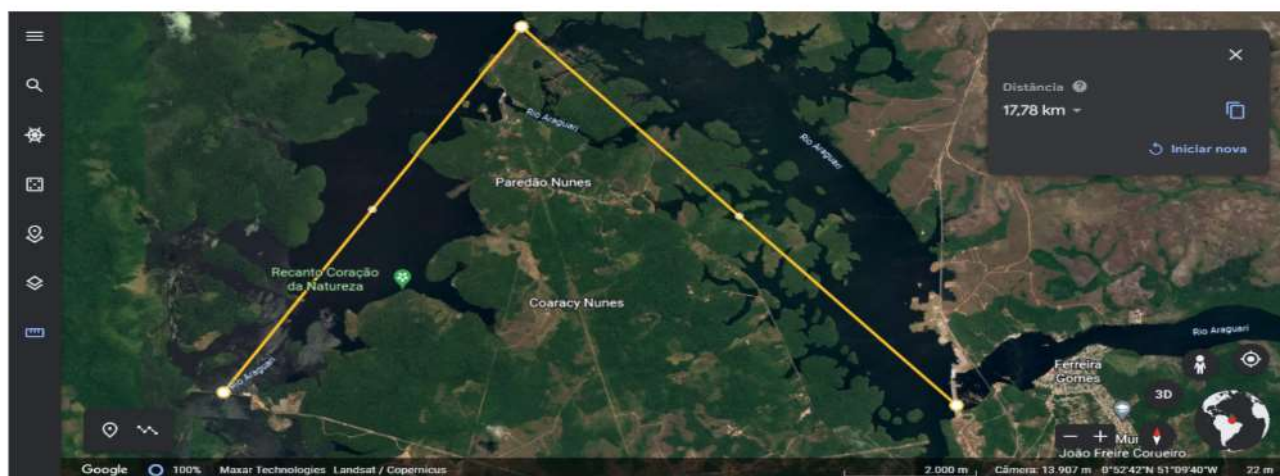
Figura 2 | Vista aérea das barragens das UHEs Ferreira Gomes e Energia, Coaracy Nunes e Cachoeira Caldeirão, Amapá, Brasil
