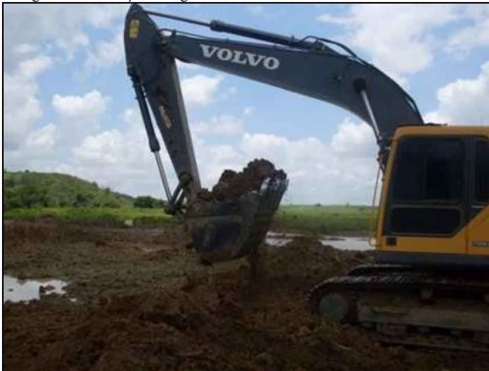
Fotografia 4 – Extração de argila de forma mecanizada com uso de escavadeira
