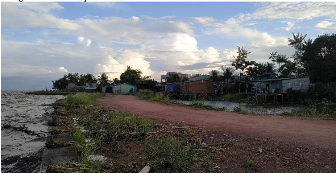
Fotografia 3: Trecho que serão realizadas as obras na orla do Aturiá no Araxá.
