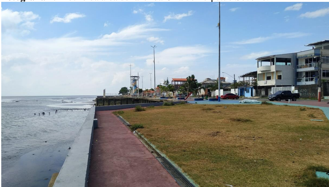
Fotografia 4: Trecho da área de lazer da Orla do Perpétuo Socorro.
