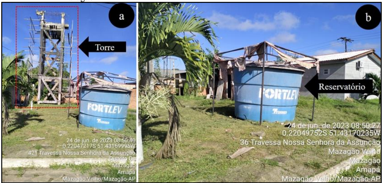
Fotografia 5 – Sistema de abastecimento de água desativado na sede do Distrito de Mazagão Velho, Mazagão-AP
