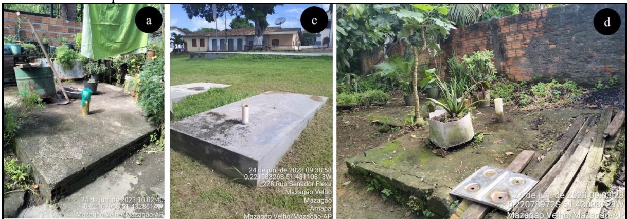
Fotografia 8 - Sistema de esgotamento sanitário no Distrito de Mazagão Velho. (a, b e c) fossas sépticas
