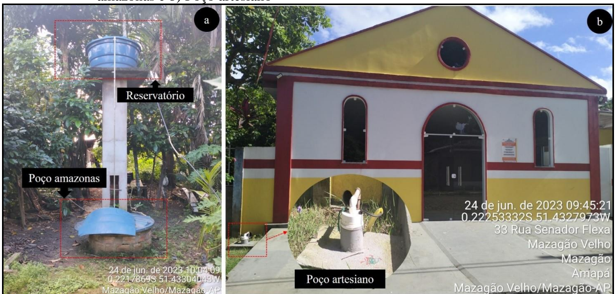
Fotografia 6 – Sistema alternativo de abastecimento de água no Distrito de Mazagão Velho: a) Poço amazonas e b) Poço artesiano
