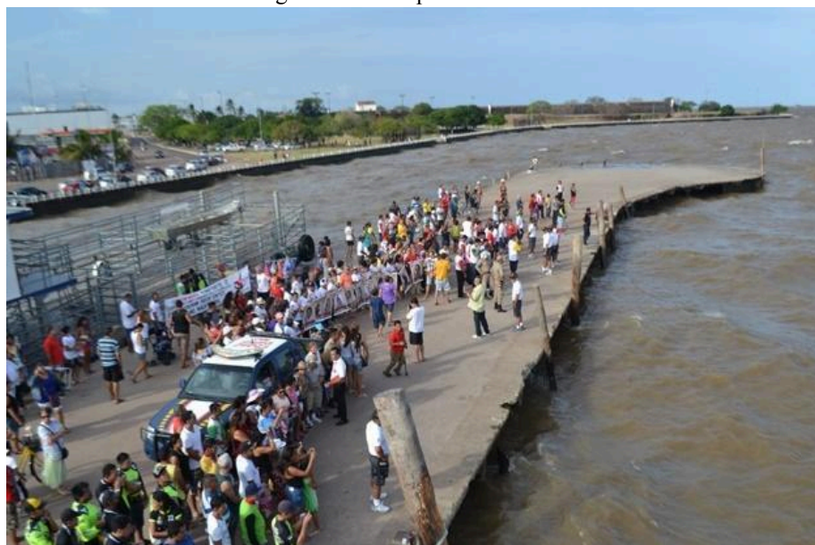
Figura 20 – Rampa do Santa Inês
