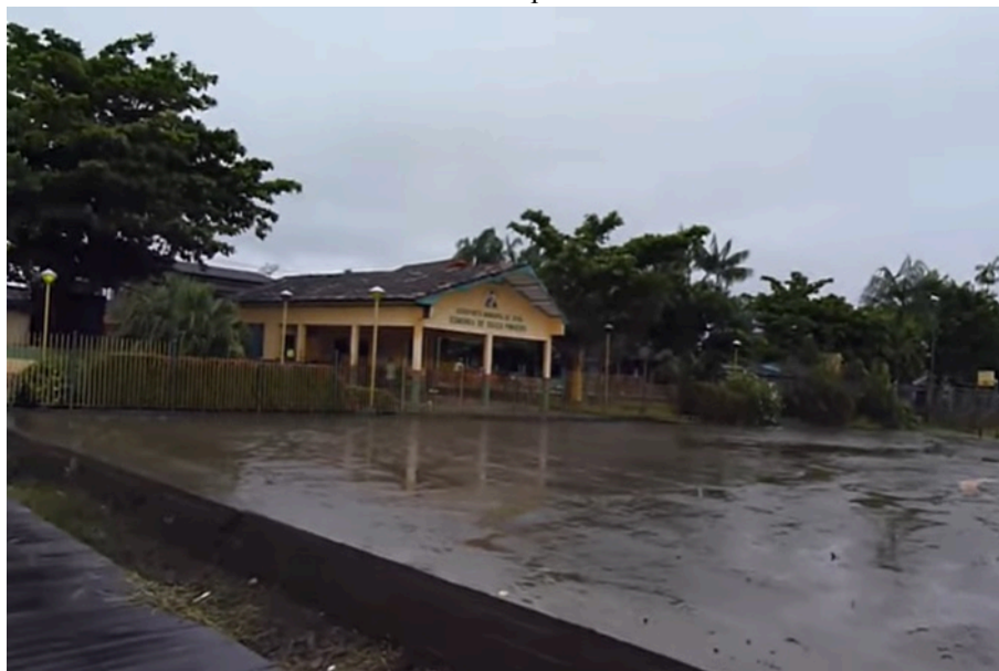
Figura 9 – Edificação intitulado “Aeroporto de Afuá” (PA), local de administração de voos comerciais do município
