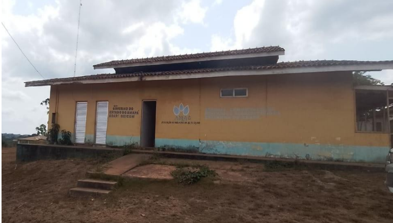
Fotografia 11 – Fachada externa da cozinha comunitária da AMAC
