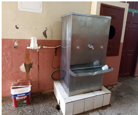
Foto 15 -Bebedouro da Escola C
