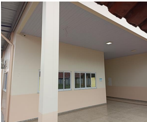
Foto 8- Bloco ampliado da Escola B.
