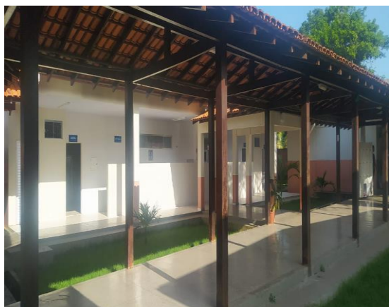
Foto 2- Refeitório reformado da Escola A
