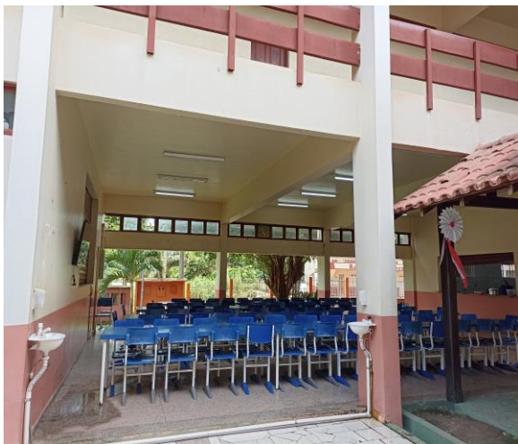
Foto 14 -Refeitório da Escola C
