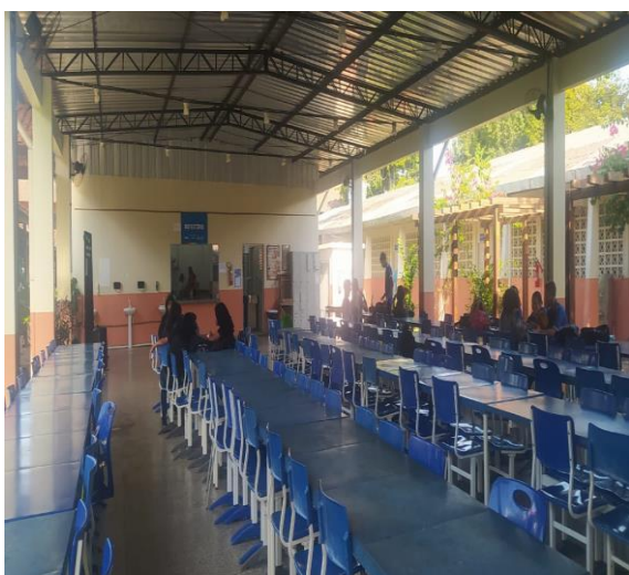
Foto 4- Corredor reformado da Escola A
