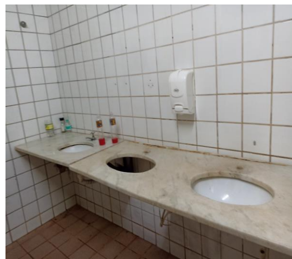
Foto 17 -Banheiro Feminino da Escola C
