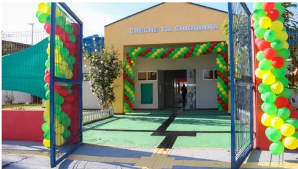
Figura 18 – Entrada da Creche Tia Chiquinha, após reforma em 2022
