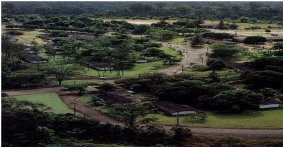
Figura 5 – Infraestrutura urbana adequada para atender os objetivos da exploração do Manganês pela ICOMI
