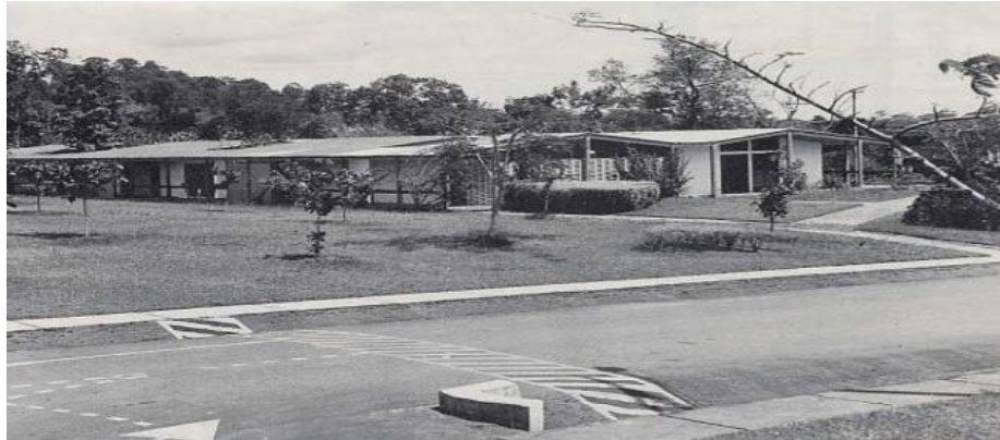
Figura 4 – Modelo de habitação construída pela ICOMI
