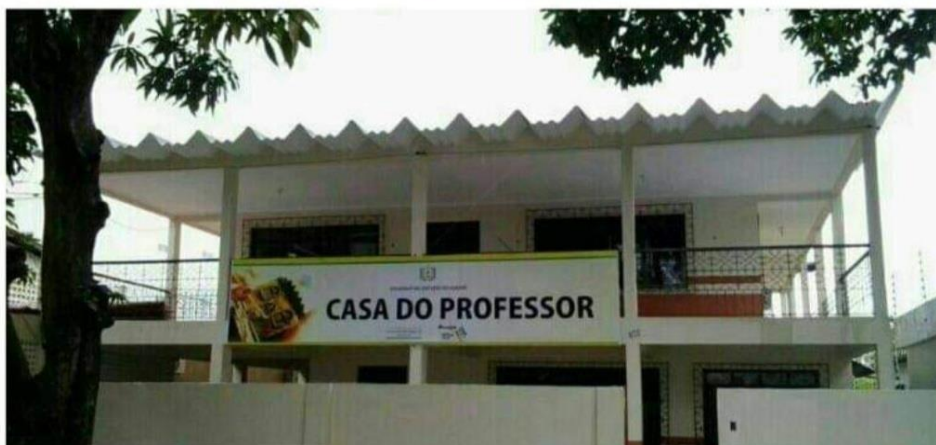
Figura 11- Prédio em que funcionava a Casa do Professor
