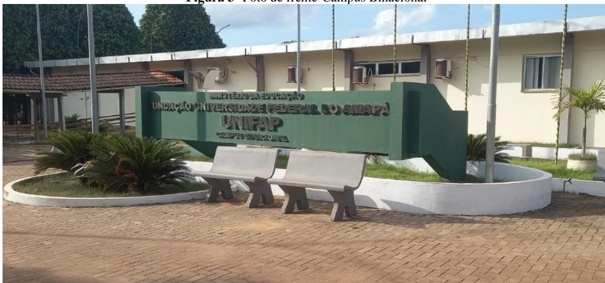
Figura 3- Foto de frente-Campus Binacional
