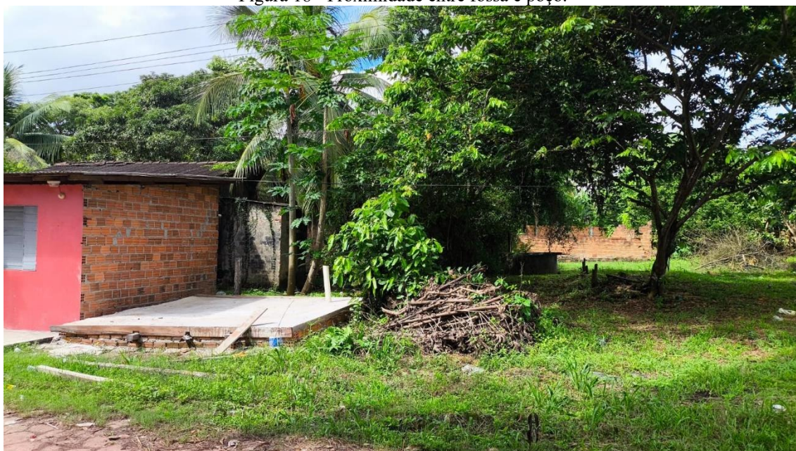
Figura 18 - Proximidade entre fossa e poço.
