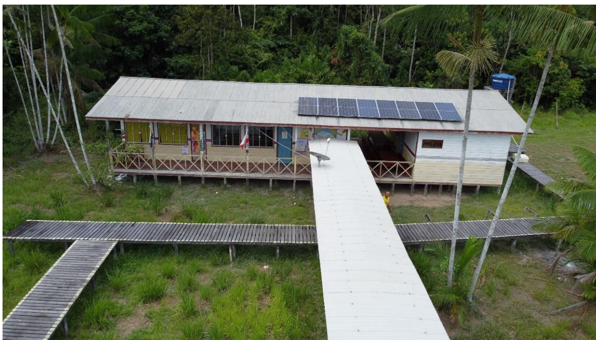
Figura 13- Escola Municipal Poção do Rio Preto construída em 2023
