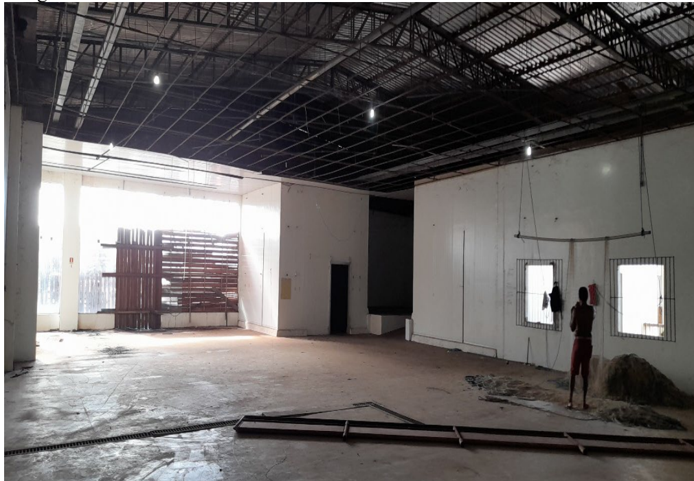
Fotografia 11 – Vista da área interna do TPP
