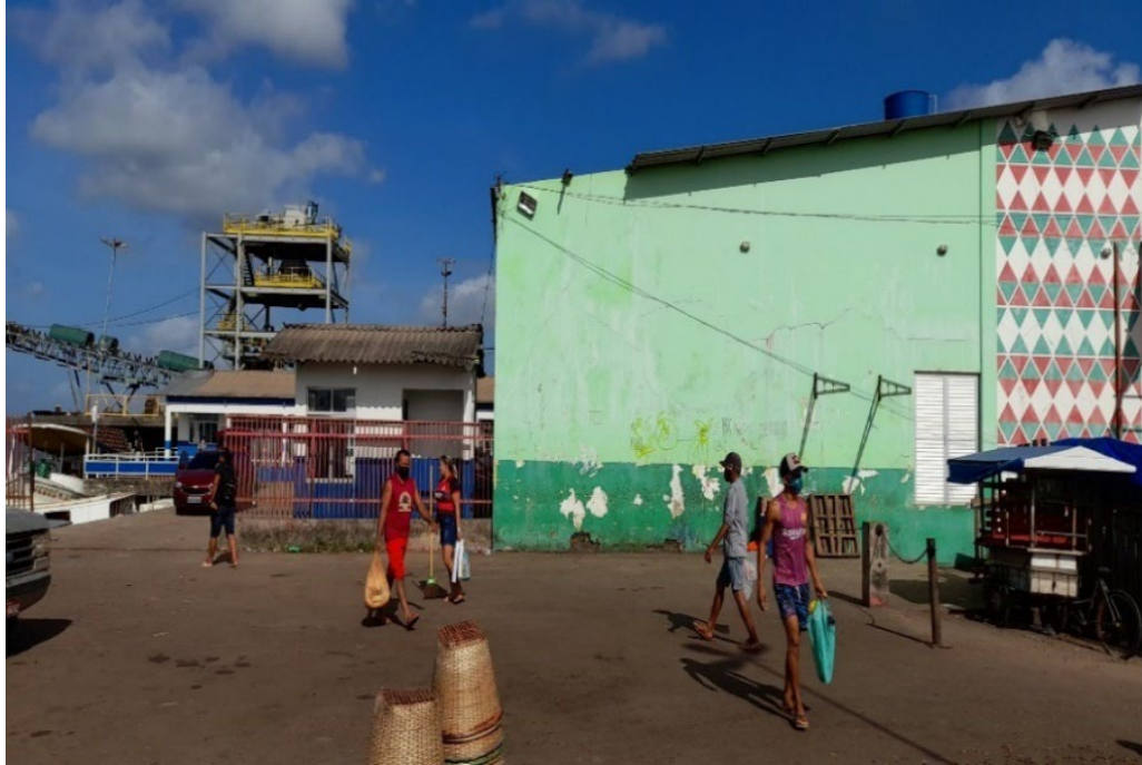
Fotografia 10 – Vista da fachada externa do TPP atualmente
