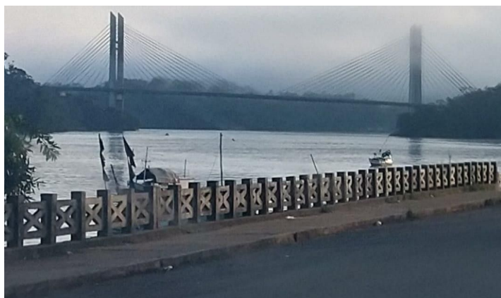
Figura 21: Ponte Binacional em fase de restrição
